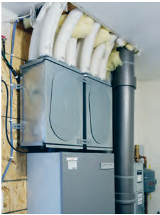
Ein installiertes Komfortlüftungsgerät Zehnder ComfoAir 350
