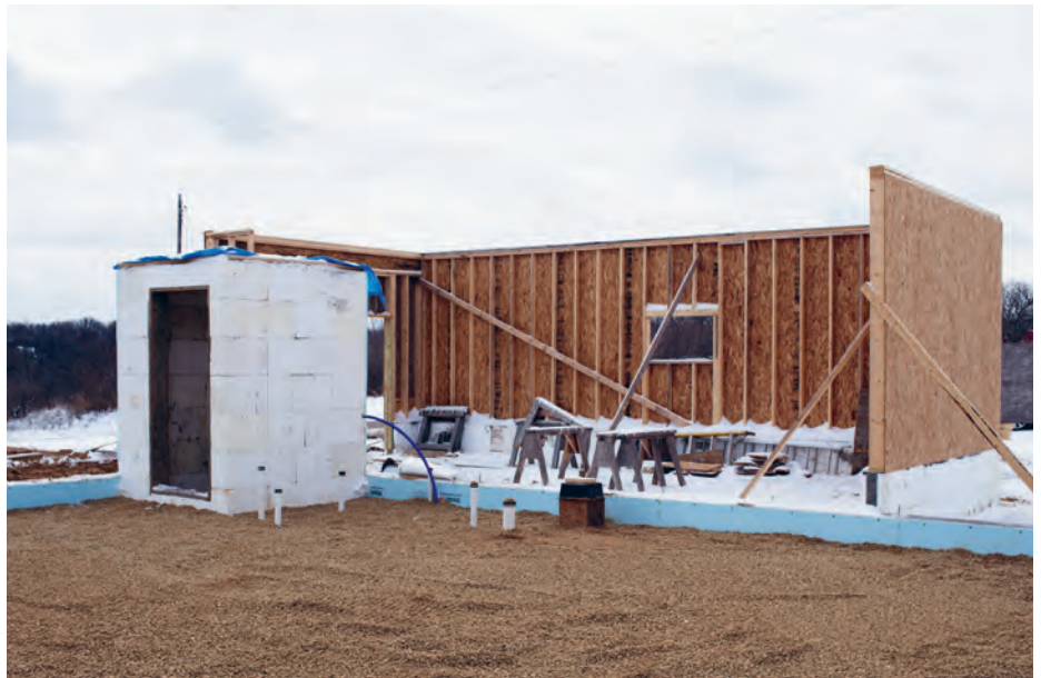
Der Rohbau eines Hauses
